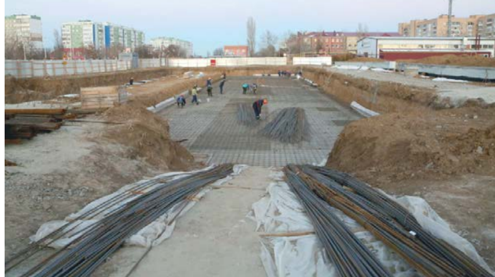
На стройплощадке будущего комплекса
